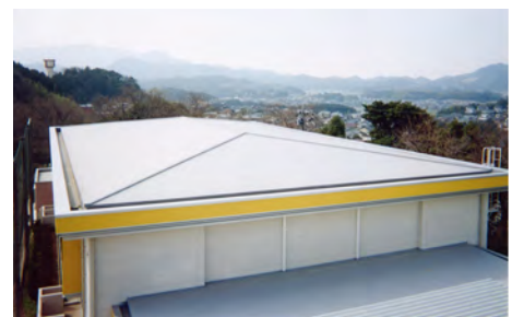
自由ヶ丘小学校体育館(瓦棒リニューアル)
